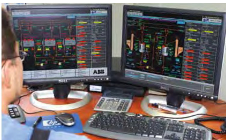
Рис. 1.4. Компьютерная система «DCS» для управления производством модифицированного битума ORBITON на установке в Плоцке (фот. «ОРЛЕН Асфальт»)
