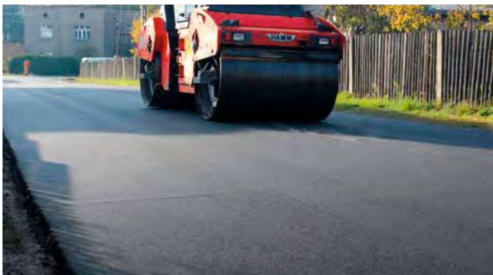
Рис. 6.7. Строительство экспериментального участка дороги с использованием ORBITON 65/105-80 HiMA в 2013 г.
