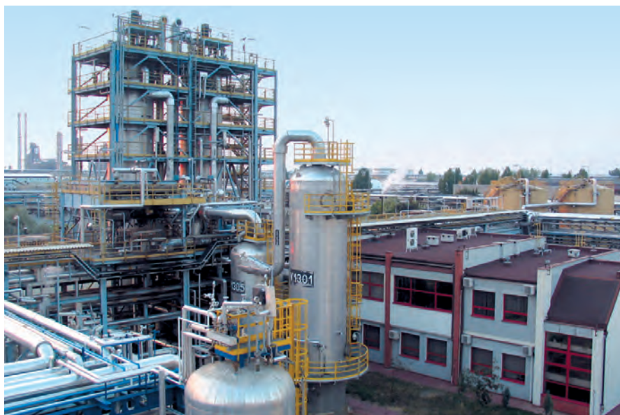
Rys. 1.3. Instalacja ciągłego utleniania – reaktory Biturox® (fot. ORLEN Asfalt)
