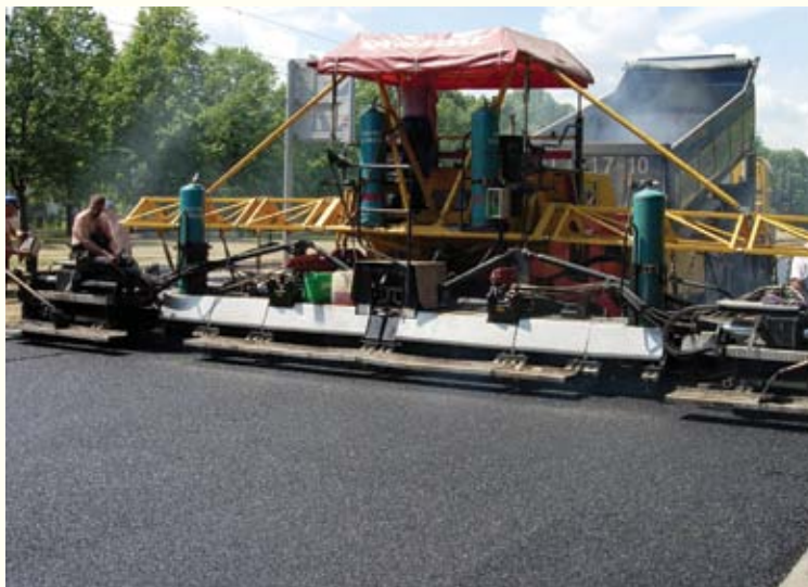
Rys. 9.4. Wbudowywanie mieszanki mineralno-asfaltowej (fot. K.Błażejowski)
