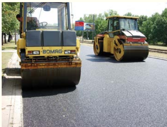
Rys. 9.5. Zagęszczanie wbudowanej warstwy (fot. K.Błażejowski)
