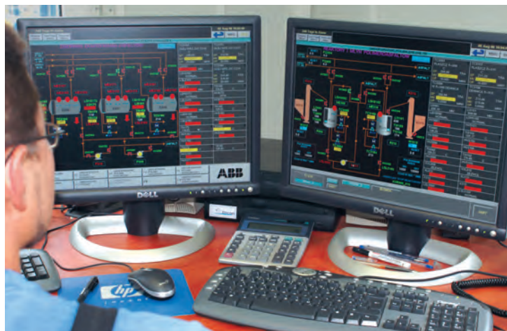
Figura 1.4. Sistemul computerizat DCS pentru controlul producției de bitumuri modificate ORBITON pe instalația din Plock (fot. ORLEN Asphalt)
