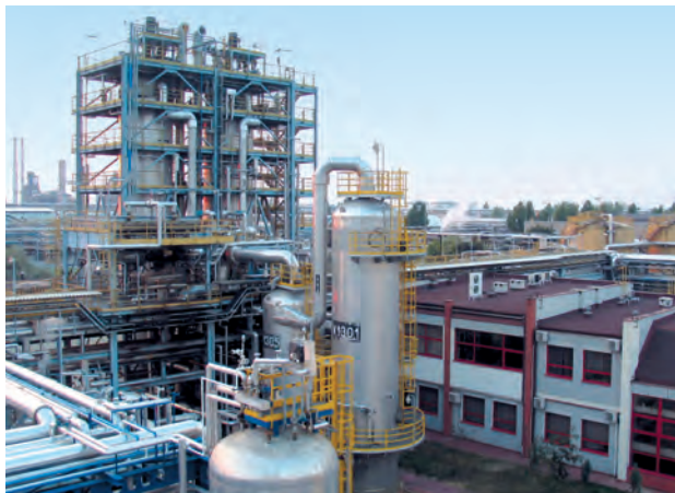
Figura 1.2. Instalația de oxidare continuă, reactoarele Biturox (fot. ORLEN Asphalt)
