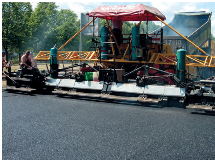
Figura 12.4. Încorporarea mixturii asfaltice (fot. K. Błażejowski)
