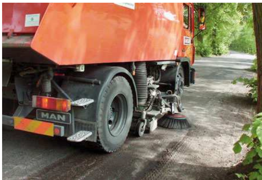
Oczyszczanie powierzchni przez rozpoczęciem robót
