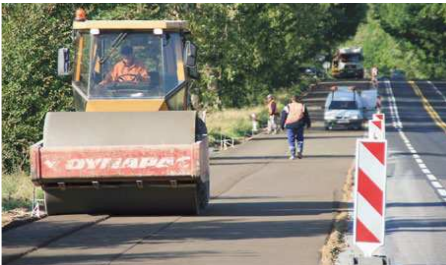
Zagęszczanie warstwy z mieszanki MCE
