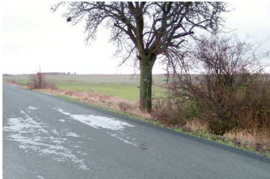
Przykład nieprawidłowego dozowania emulsji w miejscu zacienionym
